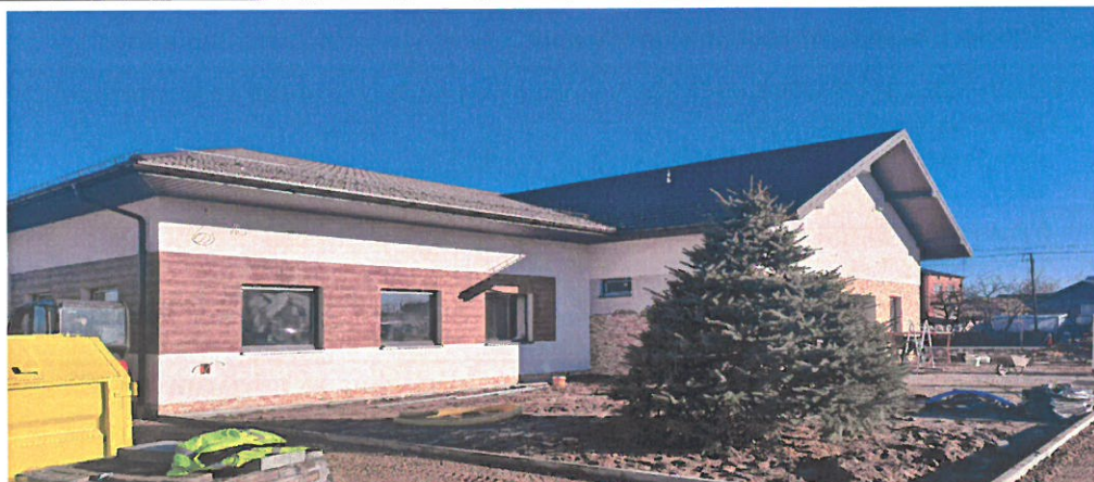
Budowa budynku usługowo-handlowego – w miejscowości Wola Baranowska
