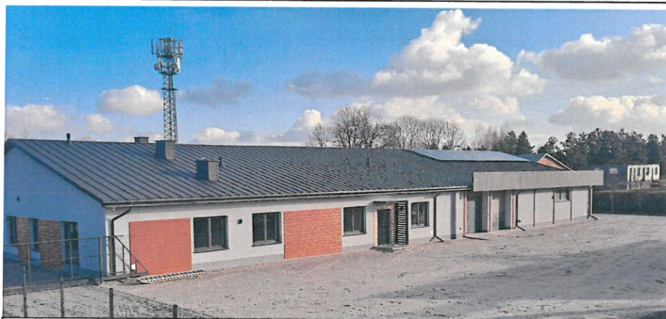
„Rewitalizacja zdegradowanego budynku wraz z otoczeniem w centrum Baranowa Sandomierskiego na potrzeby realizacji zadań statutowych Gminy”
