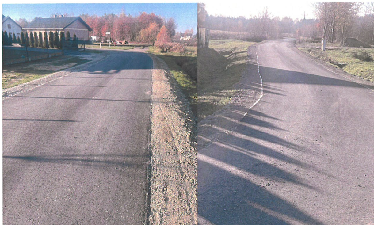
„Wykonanie nawierzchni asfaltowej na ul. Słonecznej w m. Knapy”
