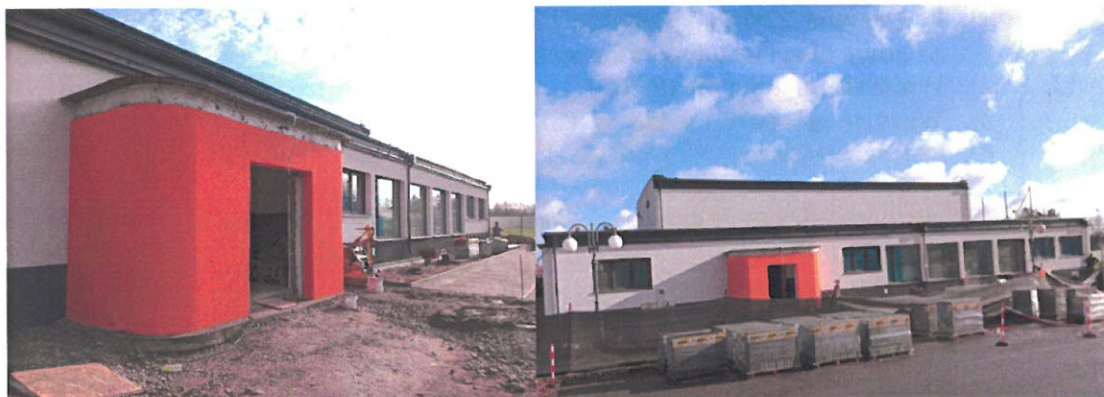
„Poprawa efektywności energetycznej Środowiskowego Domu Kultury
