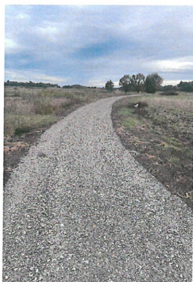
„Modernizacja drogi dojazdowej do gruntów rolnych w obrębie Dymitrów Duży”.
