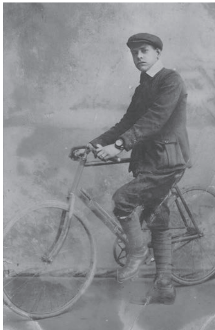
Przyszły fotograf baranowski Michał Dąbrowski, fot. M. Dąbrowski, 1925 r. Zbiory rodziny fotografa Michała Dąbrowskiego z Baranowa Sandomierskiego
