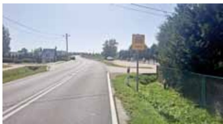
Budowa ścieżki rowerowej przy DW872 w msc. Durdy.
